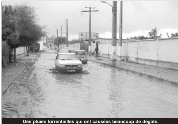
Des pluies torrentielles qui ont causées beaucoup de dégâts.
