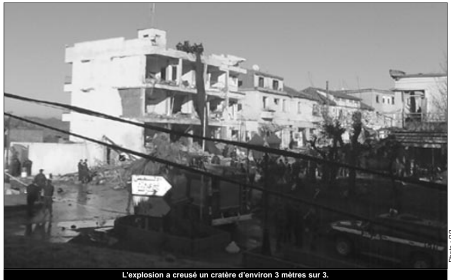
L'explosion a creusé un cratère d'environ 3 mètres sur 3.
