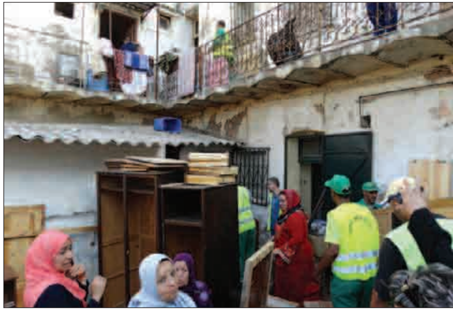
Le séisme du 1 er août a causé des dégâts au vieux bâti.
